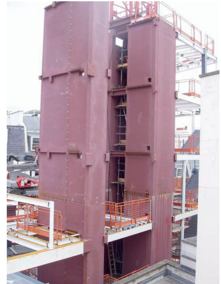
Рисунок 21 Ядро жёсткости, выполненное из стальных конструкций
