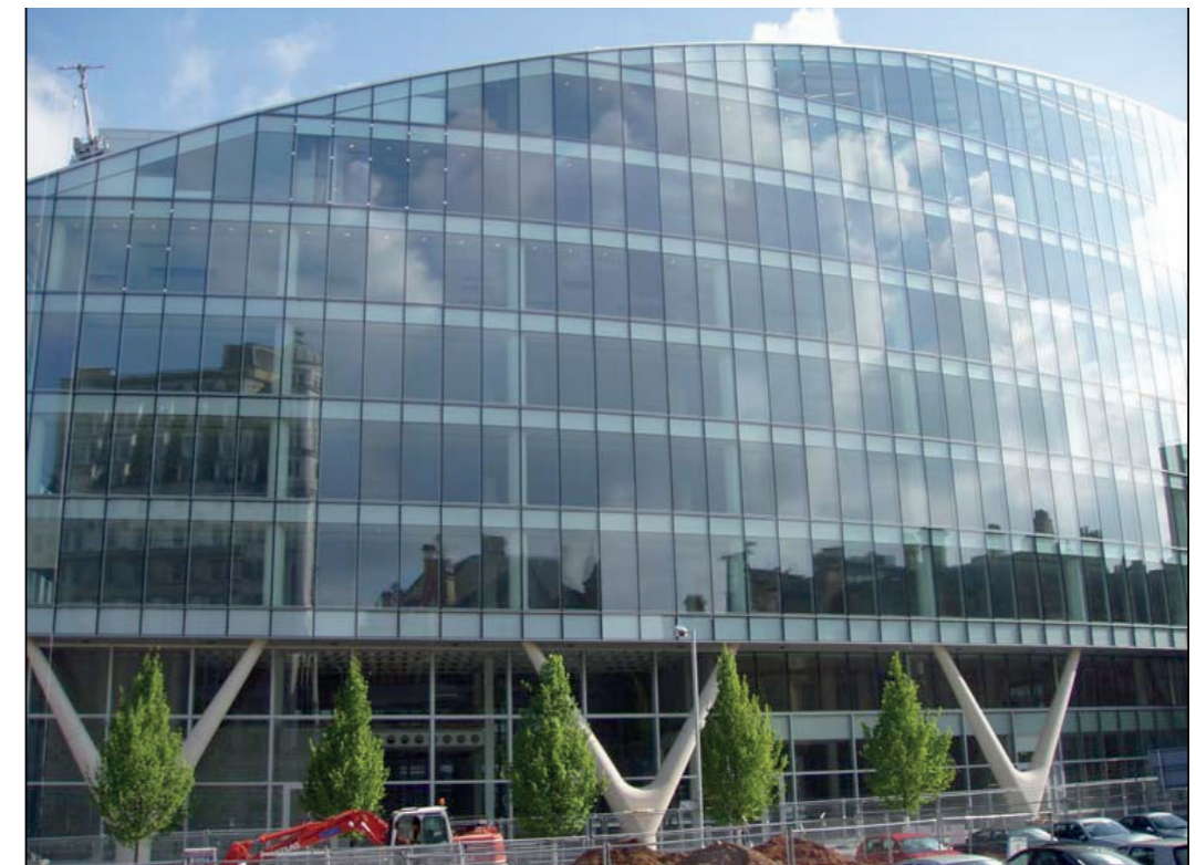
Рисунок 26 Фасадная стена с тройными стеклопакетами
