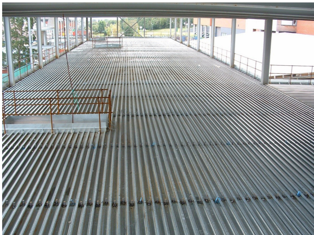
Рисунок 2 Уложенный профилированный настил создаёт удобную площадку для выполнения монтажных работ
