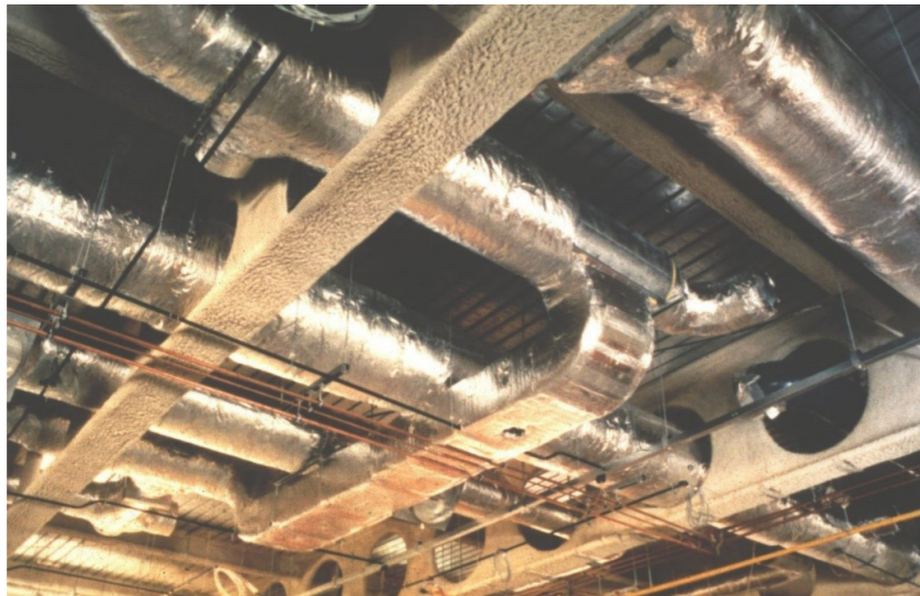
Рисунок 4 Конструкции перекрытия, покрытые огнезащитным составом
